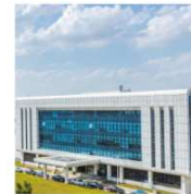
南方安美 消防泵智造基地
