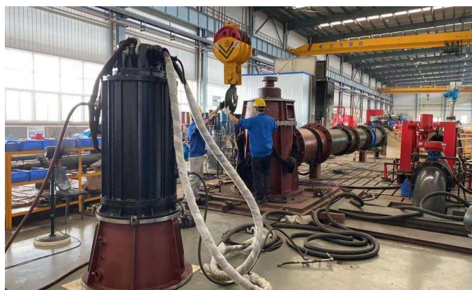
Hệ thống thoát nước đô thị Thái Lan
